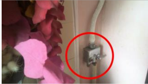
Robinets non autorisés-Date tuyau souple dépassée et sur installation rigide-DGI
